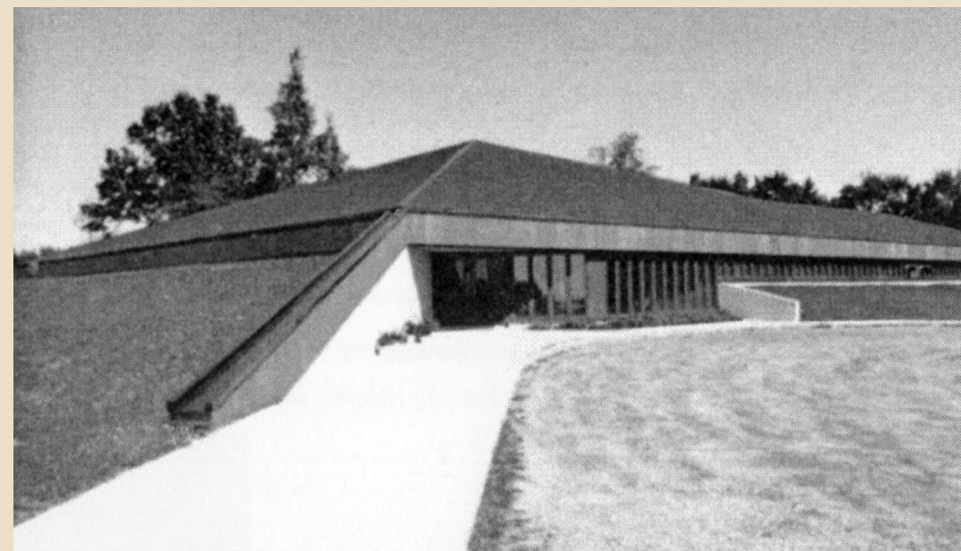
△ Kościół metodystów w Highland w stanie Michigan, 1979. Dzięki wałom ziemnym uzyskano energooszczędność bierną. Powyżej rysunek projektowy
